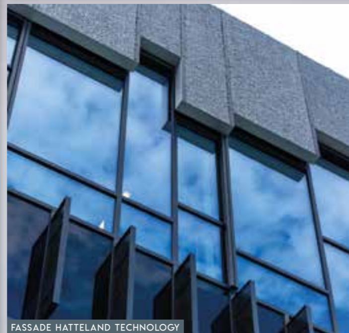
FASSADE HATTELAND TECHNOLOGY
