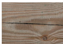
Spannungsrisse durch die Holz Trocknung
