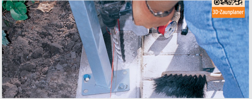
oder mit Pfostenträger aufschrauben.
