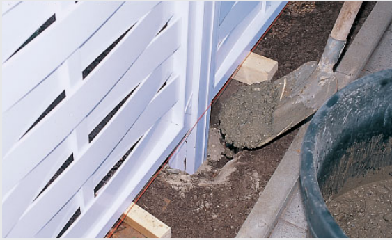
Zaunpfosten direkt ins Erdreich einbetonieren...
