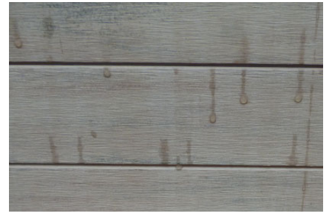
Fleckenbildung durch von Regen angelöste Partikel
