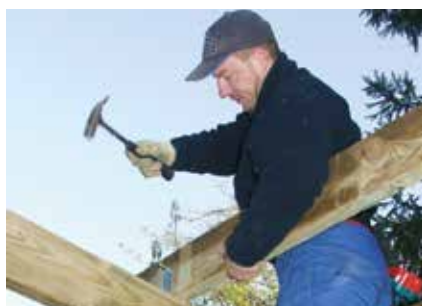
5 Die von Joda® vorgefertigten Pfetten aufsetzen und annageln. Zwischen den mittleren, oben ausgefälzten Pfetten wird die Dachrinne eingehängt.
