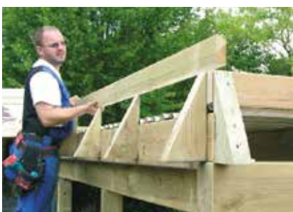
7 Die Lücke oberhalb der Dachtafeln wird durch Aufkantungsbretter gefüllt. Diese dienen auch als Auflage für die Kranzleisten.
