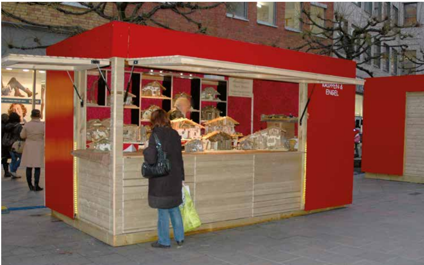
Individuelle Markthütte in Elementbauweise mit Fassadenplatten und Holzprofilen. Dach mit EPDM-Folie
