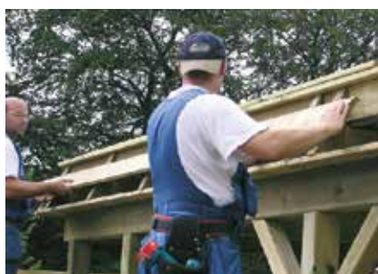
8 Die massive Holzverkleidung einer Walmblende: Glattkant-Bretter sind umlaufend an den Walmklötzen anzuschrauben.
