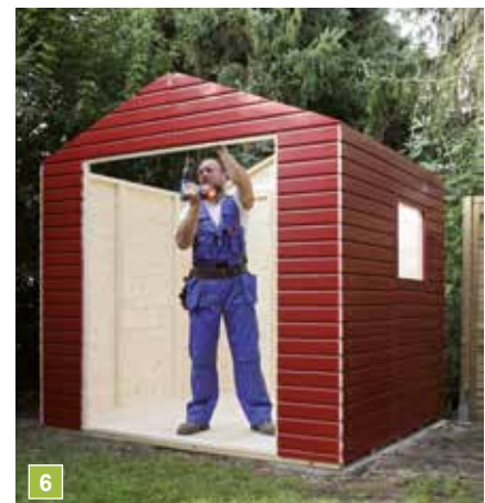
6 Alle Wandelemente stehen. Die zweifarbigem Giebeldreiecke schrauben Sie stirnseitig auf. Die Hausform wird sichtbar.
