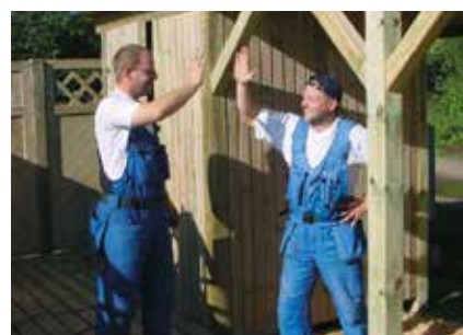
12 Dank vorgefertigter Bauteile und vielfach praxisbewährter Bausatz-Konstruktion: Sieht gut aus und passt perfekt.
