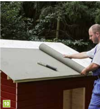
10 Die Dach-Eindeckung: Die 1. Lage Dachpappe liegt dem Bausatz bei. Start von der Traufseite. 2. Lage bauseits ergänzen.
