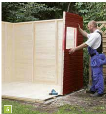
5 Gemäß Bauplan setzen Sie die rechteckigen Wandelemente immer weiter aneinander. Die Fensterposition ist wählbar.
