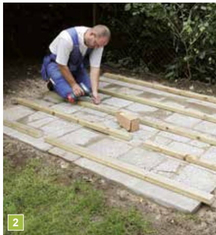
2 Fußboden-Lagerhölzer (40/60 mm), hier auf Waschbetonplatten ausgerichtet, werden auf dem Untergrund befestigt.
