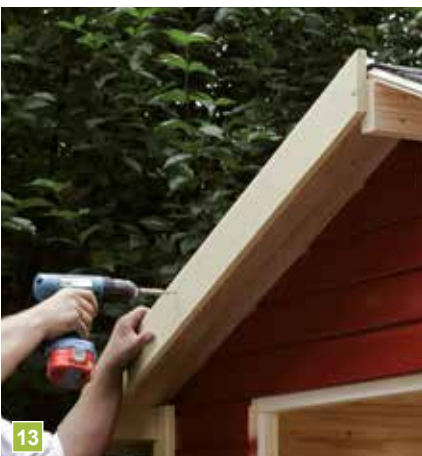
13 Montage der Stirnbretter. Die bereits fertig abgelegten Bretter schließen die Dachhaut stirnseitig perfekt ab.
