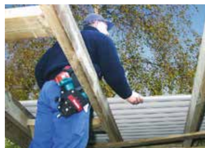
6 Das Dach: hier Bedachung mit großformatigen Trapezblechen. Einfach auflegen, ausrichten und mit Spezialschrauben im „Tal“ festschrauben.
