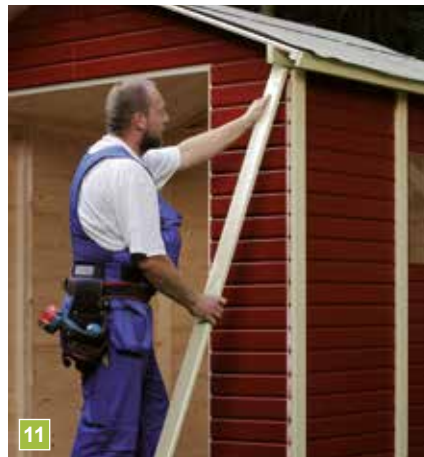
11 Die lackierten Abdeckleisten aus dem Bausatzpaket setzen Sie auf die schmalen Fugen an den Ecken und zwischen den Wandelementen.
