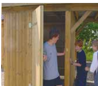
10 Einzeltür, Massivholzrahmen, inklusive verzinkter Beschläge
