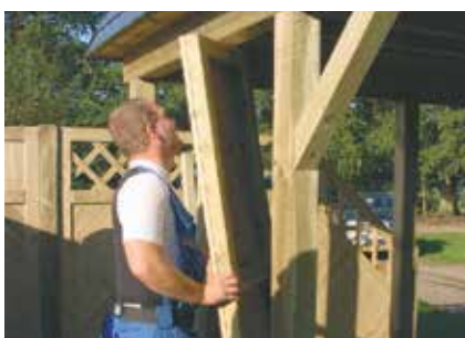
11 Optional: Geräteraume schaffen extra Stauraum und Windschutz. Fertige Wände zwischen die Pfosten schrauben.
