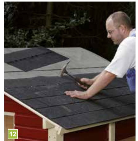
12 Hier dienen optionale Bitumenschindeln als zweite Dachlage (zwingend erforderlich). Diese Schindeln erhalten Sie auch in weiteren Farben und Formen.
