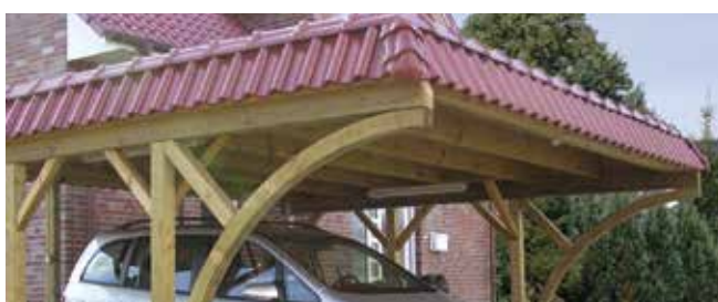
Breite Einfahrt: Pfostenbögen aus Leimholz
