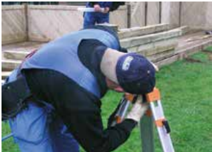
1 Bestimmen und markieren Sie die Position der Fundament- bzw. Pfostenlöcher zur Aufnahme der tragenden Pfosten genau.
