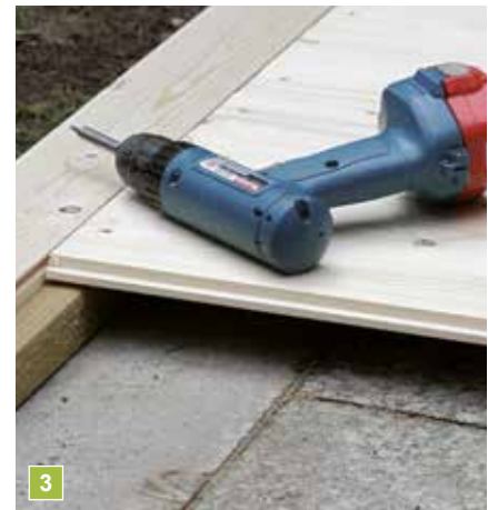
3 Die Fußbodendielen sind schon fertig abgelängt. Nur noch an die Lagerhölzer nageln oder verschrauben.
