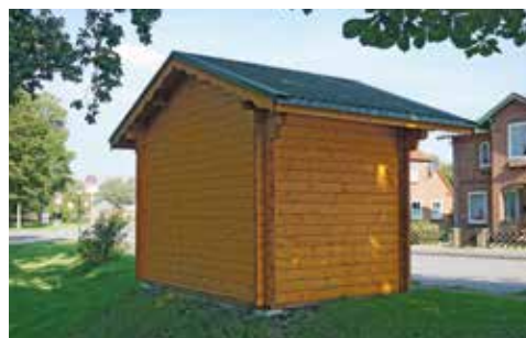
Rückansicht des oben gezeigten Bushäuschens (bauseits farbbehandelt)
