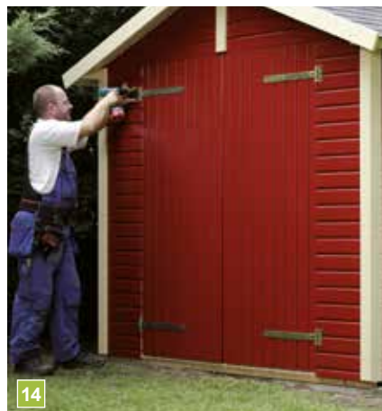
14 Auch die Türflügel liegen fertig im Paket. Ausrichten und rostfreie Scharniere anschrauben.
