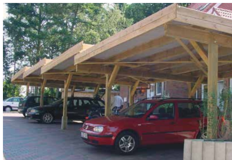
Mit Höhen-Versatz: Die Flachdach-Reihenanlage am Hang schafft viele Stellplätze auf kompaktem Raum
