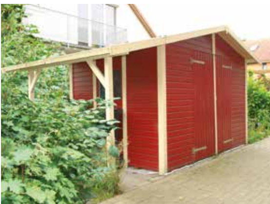
„Nordic 30/23“ mit Schlepptdach, Schwedenrot, fertig gestrichen
