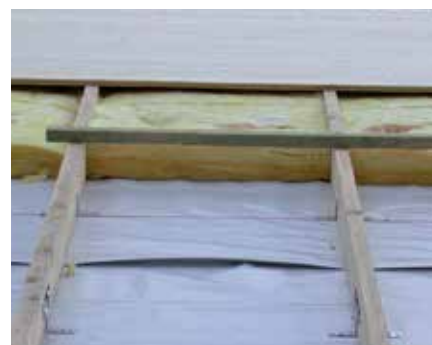
Das doppelschalige Dach für frostige Tage – zur Aufnahme der Dämmung vorbereitet
