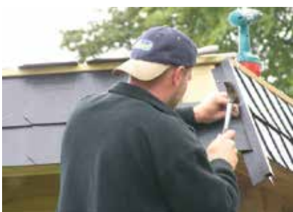
10 Die Blendenbekleidung: hier Deckung mit Faserzement-Schindeln. Sauberer Abschluss durch Kantenprofile.
