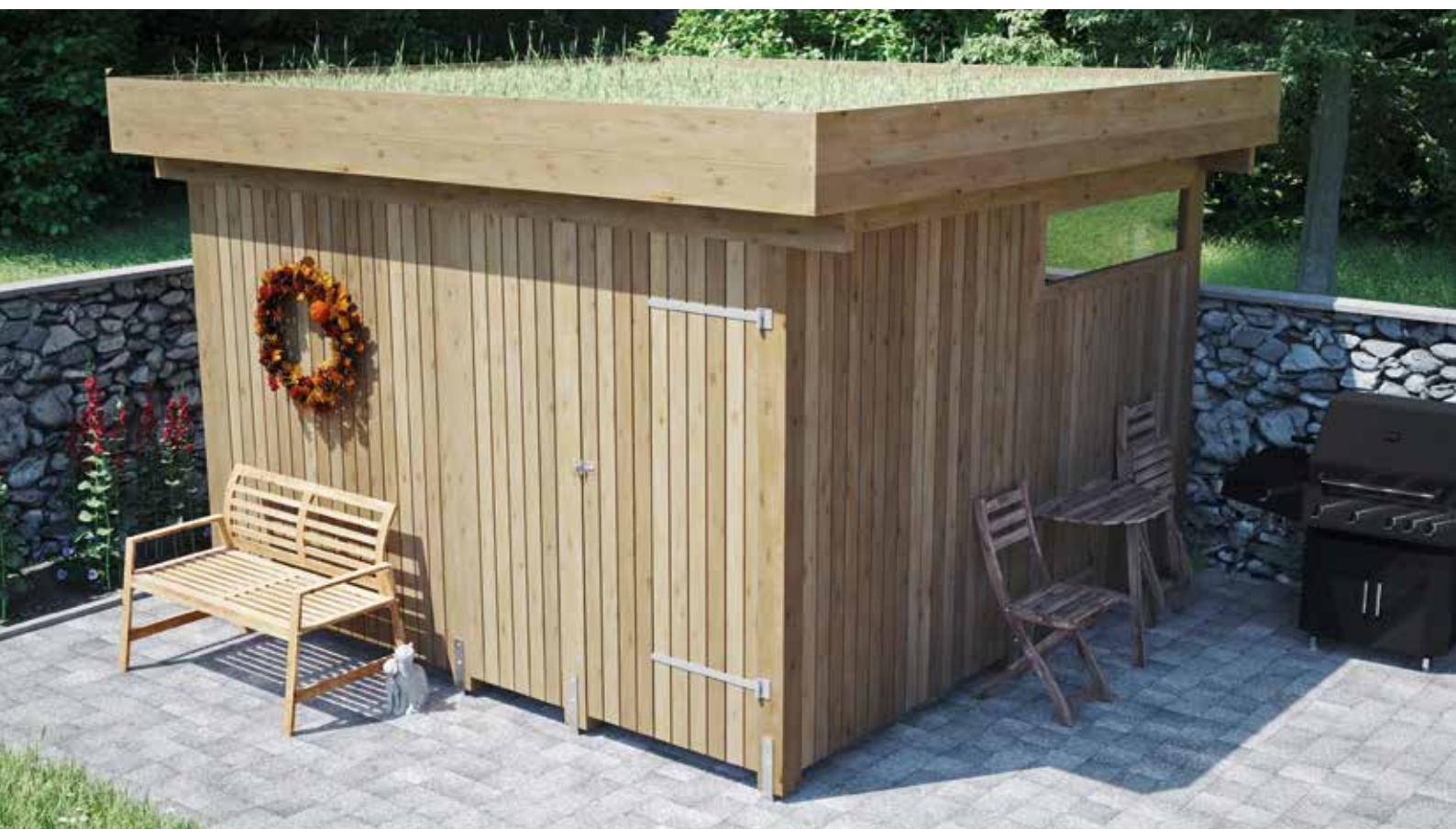
Freistehender Geräteraum „Preetz Natur“
