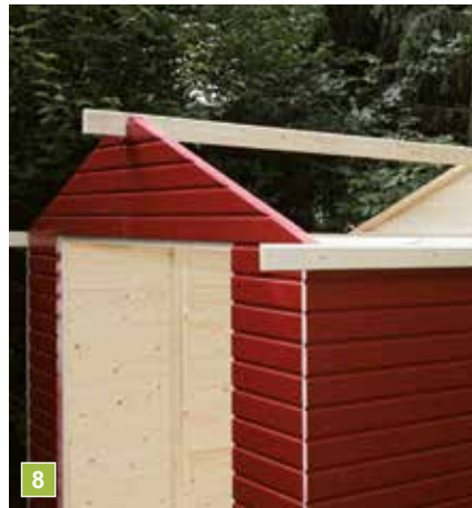
8 Für die Dachmontage setzen Sie die glatt gehobelte Firstpfette mittig in die vorbereiteten Aussparungen des Giebels.
