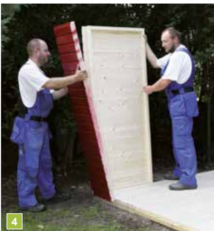
4 Alle Wandelemente des Bausatzes sind bereits fertig. Elemente auf die Ecke aufsetzen und miteinander verschrauben.
