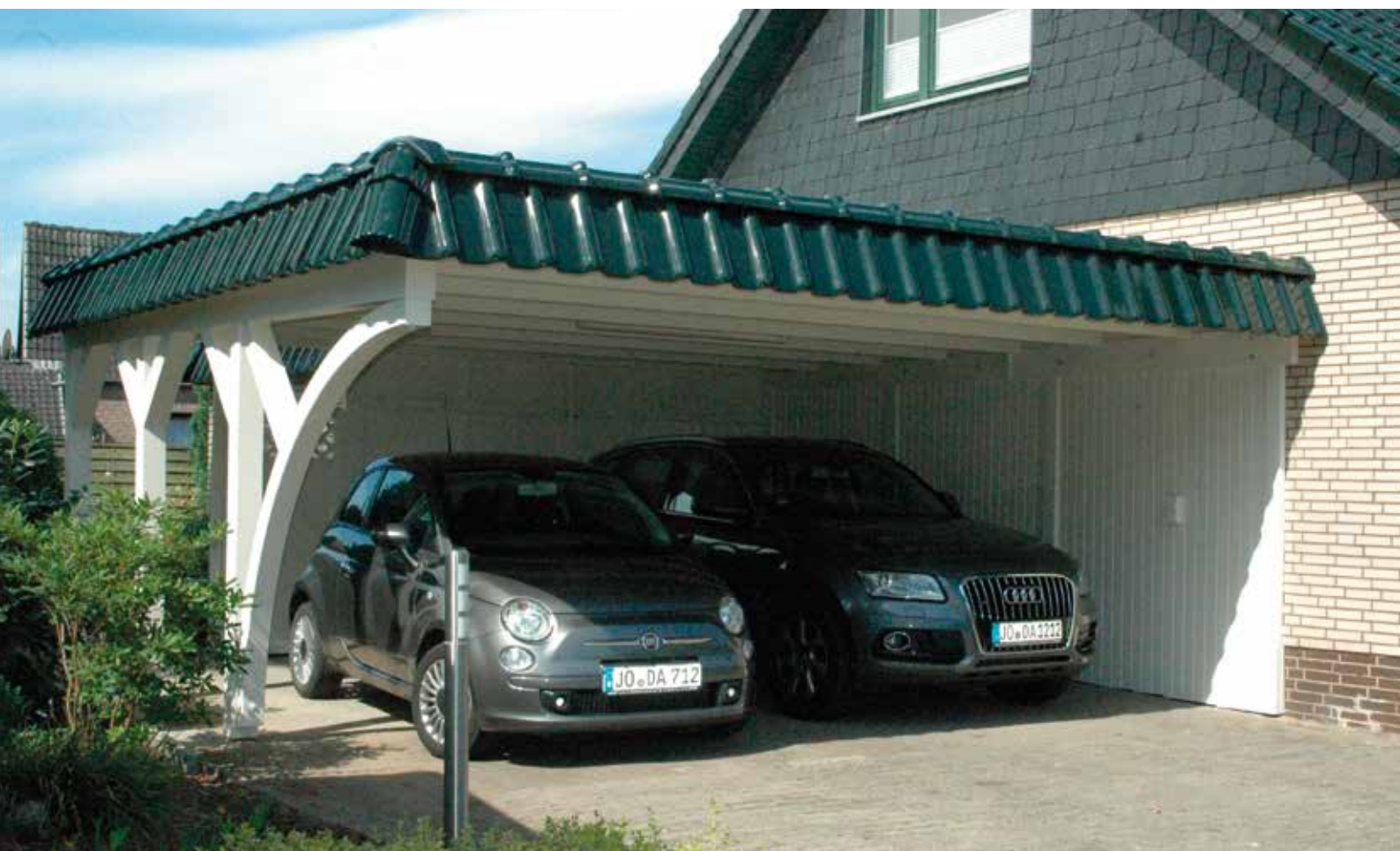
Wandbau-Lösung mit einreihiger Pfannenwalblende
