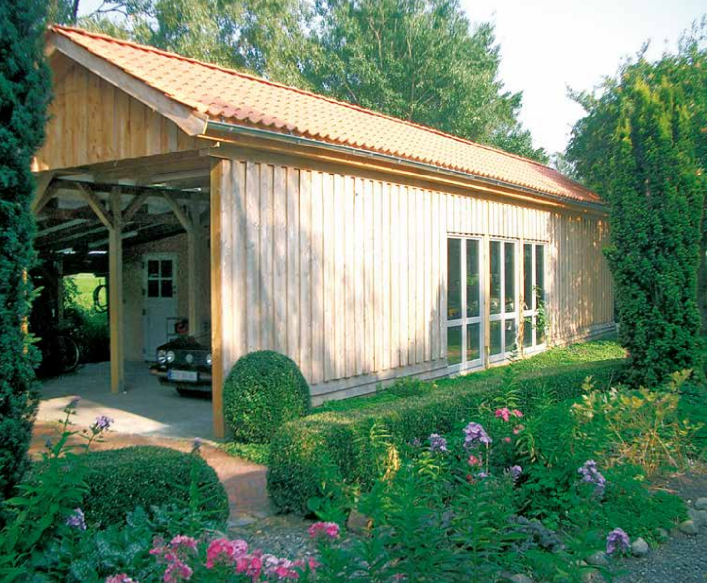
Satteldach-Carportlösung mit individueller Wandgestaltung (sogenannter „Boden-Deckel-Schalung“)
