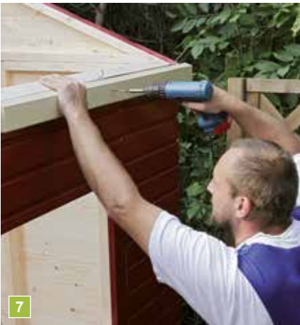
7 Vorbereitung der Dachmontage: Die Giebeldreiecke werden ergänzt durch die seitlichen Auflager für die Dachbretter.
