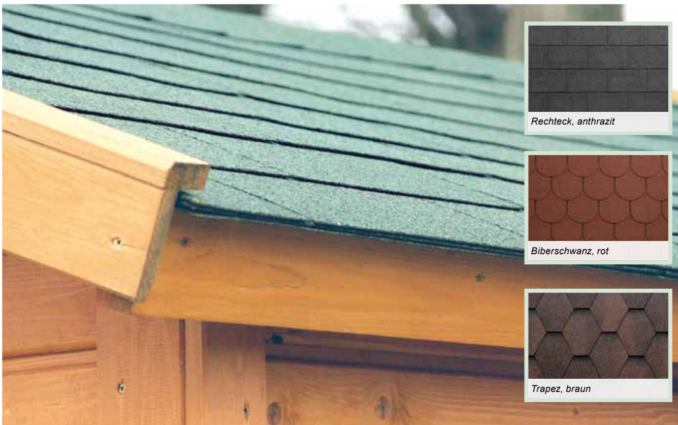
Bewährter Schutz - schnell und einfach zu montieren: Bitumen-Dachschindeln erhalten Sie in vier beliebigen Farben und drei Formen.
