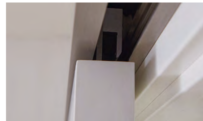
Befestigung einer Holztür im Schiebetürbeschlag LINE
