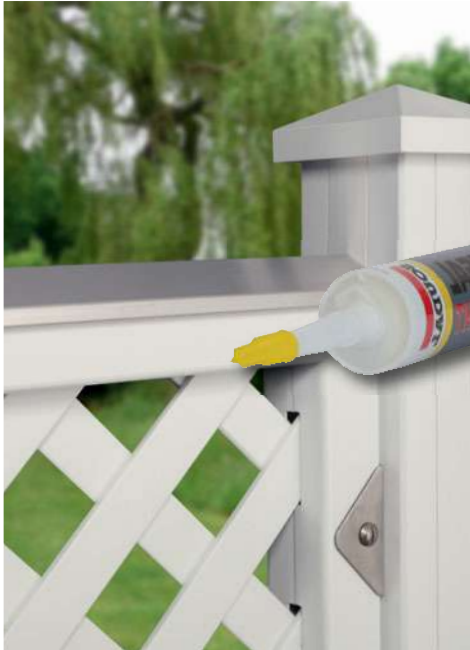
Designaufsatz Alu mit MS-Polymer-Kleber (1398) befestigen.
