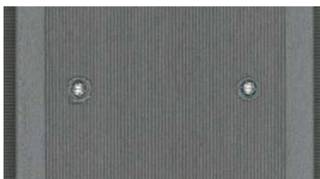
Produktionsrückstände an den Verschraubungen der JUMBO WPC Profile
