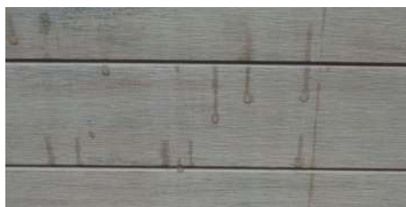
Fleckenbildung durch von Regen angelöste Partikel
